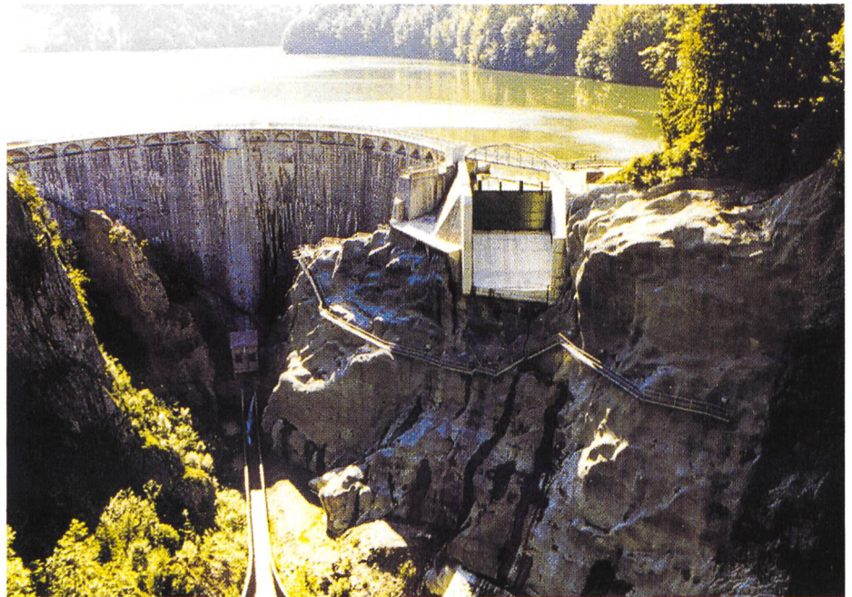
Figure 2. Vue d'ensemble du barrage et de l'appui gauche après les travaux d'assainissement. En premier plan l'évacuateur de crues en rive gauche avec l'installation des vannes du type Hydroplus (Photo Hydroplus).
