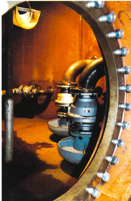
Innenliegender Tank-Kugelhahn.
