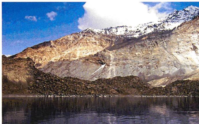
Bild 3. Usoi-Damm und Lake Sarez, welcher 1911 während eines starken Erdbebens in Tajikistan durch einen Fels- und Gletscherabbruch gebildet wurde. Klar erkennbar ist die Anrissstelle des Felssturzgebietes am rechten Ufer (maximale Dammhöhe ca. 650 m; Freibord ca. 50 m; Volumen des Felssturzdammes ca. 2 km 3 ).
