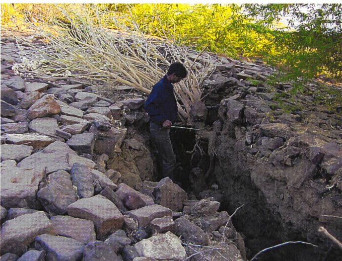
Bild 2. Risse in wasserseitiger Böschung und im Kronenbereich von zwei Schüttdämmen, die während des Bhuj-Erdbebens vom 26. Januar 2001 in Indien beschädigt wurden. (Fotos: Prof. S. K. Jain)
