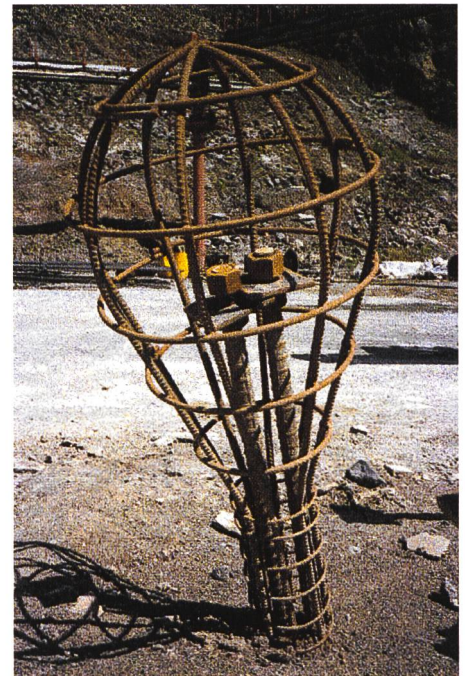
Bild 1. Bewehrungskorb zur Verbesserung der Kräfteinleitung von der Stau-mauer in den Felsnagel (Egger, EPFL).
