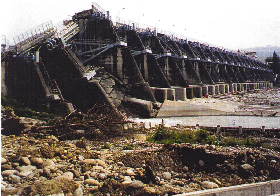
Bild 1. Schäden am Shih-Kang-Wehr in Taiwan, welche im Bereich des rechten Widerlagers durch vertikale Relativverschiebungen von 7,7 m entlang der Chelungpu-Verwerfung, während des Chi-Chi-Erdbebens vom 21. September 1999 in Taiwan, entstanden. Abgescherter Wehrpfeiler neben den zerstörten zwei Wehröffnungen. (Fotos: P. F. Foster und R. Charlwood)
