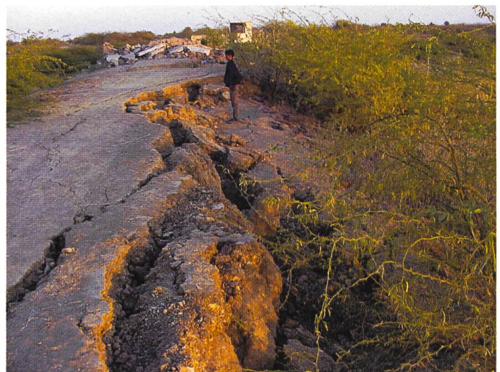
Bild 2. Risse in wasserseitiger Böschung und im Kronenbereich von zwei Schüttdämmen, die während des Bhuj-Erdbebens vom 26. Januar 2001 in Indien beschädigt wurden. (Fotos: Prof. S. K. Jain)
