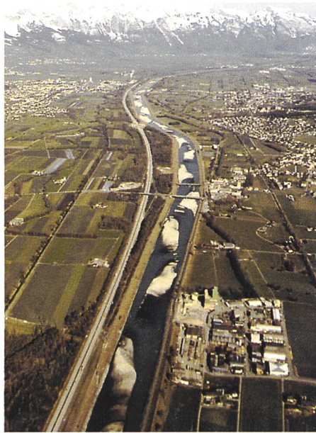
Bild 2. Rhein Triesen – Vaduz mit alternierenden Bänke (ähnlich wie Teststrecken Bad Ragaz und Buchs). Blick in Flieβsrichtung.
