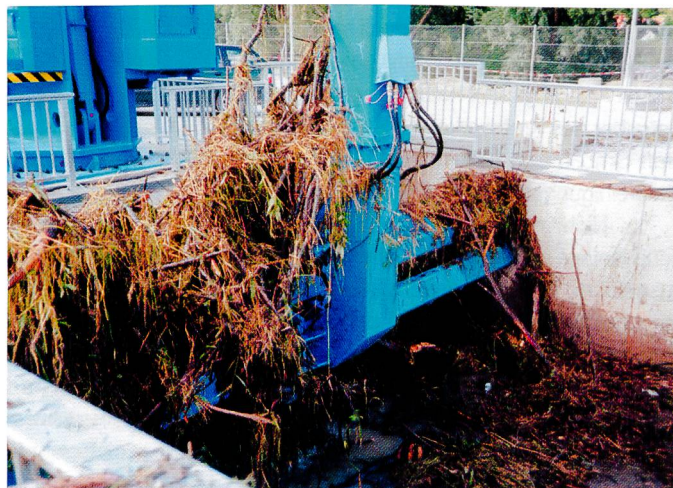
Bild 5. Greiferharke schliesst sich über der Wasseroberfläche.
