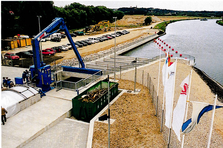
Bild 1. Gesamtansicht Bad Abbach.
