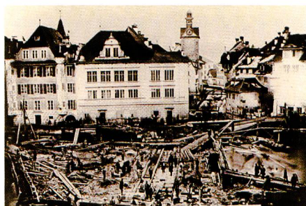
Bild 3. Um die Hochwasser einzudämmen, wurde 1859/60 das Nadelwehr errichtet, das eine Regulierung der Seehöhe zulässt (Bild aus Postkartenbuch der «Stadt Luzern in alten Ansichten»).
