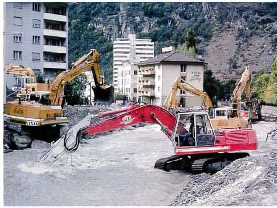
Fig. 9. Intervention des pelles mécaniques lors de la catastrophe de Brigue (1993).
