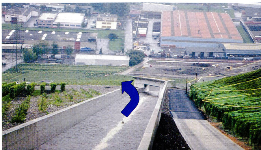
Fig. 8. Déviateur de lave torrentielle sur le Pissot (Villeneuve VD).
