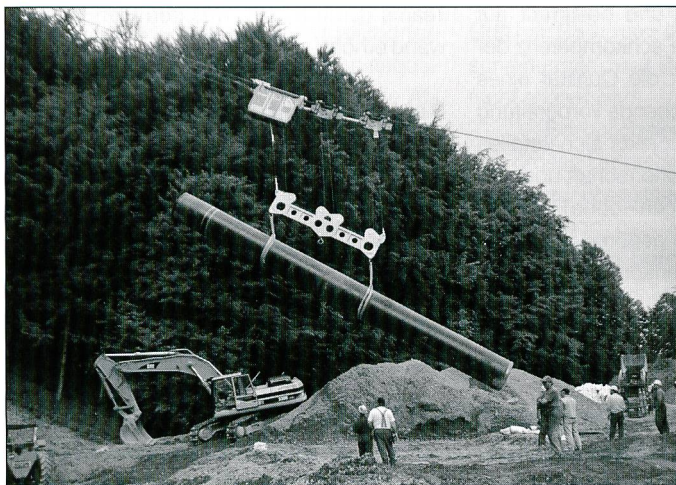
Transport und Versetzen Erdgasleitung, Rohrgewicht 12 Tonnen
