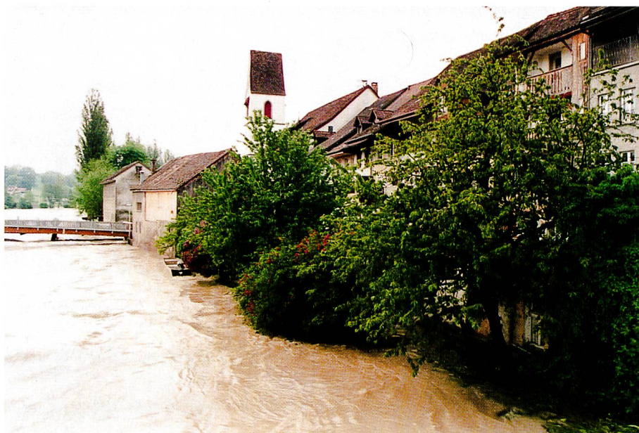
Bild 2. Hochwasser 1999 an der Reuss in Melligen.
