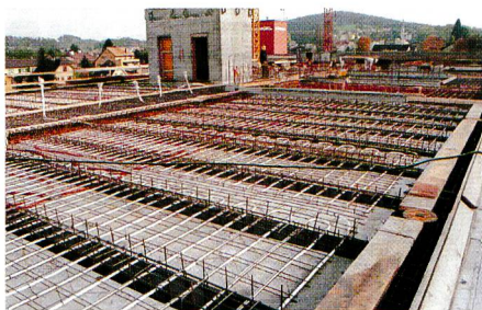
Vor dem Betonieren werden die Kunststoffrohre (weiss) des thermoaktiven Bauteils fest mit der Armierung verbunden (Foto: Martina Peter).
