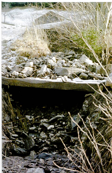
Bild 14. Beim Ereignis vom 15. bis 17. November 2002 verklebten zahlreiche Brücken über Wildbäche in den Emser Maiensässen, teilweise nur durch Geschiebe (links) oder durch Holz und Geschiebe (rechts).
