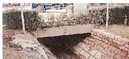
Bild 15. Die Baumstämme (links) passierten den Durchlass des Dorfbaches unter der Kantonsstrasse (rechts) beim Ereignis vom 15. August 1997 in Sachseln, obwohl deren kleinste Abmessungen in der Grössenordnung des Durchlasses lagen.
