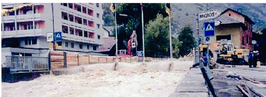
Bild 11. Die im Sommer 2000 realisierten Sofortmassnahmen (überflutbare Brücke mittels seitlicher Dammbalken) verhinderten am 15. Oktober 2000 einen Ausbruch der Lonza im Bereich des Gefällsknickes in die Dörfer Gampel und Steg.
