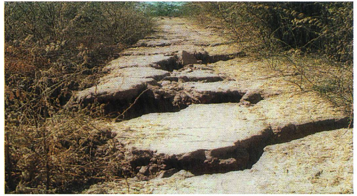
Bild 2. Erdbebenschäden an zwei Schüttdämmen (links: Shivlakra-Damm mit wasserseitiger Rutschung, rechts: massive Querrisse und Setzungen im Chang-Damm), die während des Bhuj-Erdbebens vom 26. Januar 2001 in Indien beschädigt wurden. Insgesamt mussten bei rund 245 Dämmen Reparatur- und Verstärkungsmassnahmen getroffen werden (Fotos: Prof. S. K. Jain und M. S. Patel).
