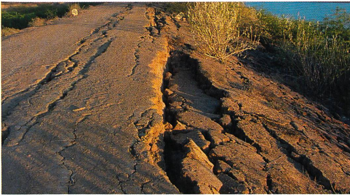
Bild 2. Erdbebenschäden an zwei Schüttdämmen (links: Shivlakra-Damm mit wasserseitiger Rutschung, rechts: massive Querrisse und Setzungen im Chang-Damm), die während des Bhuj-Erdbebens vom 26. Januar 2001 in Indien beschädigt wurden. Insgesamt mussten bei rund 245 Dämmen Reparatur- und Verstärkungsmassnahmen getroffen werden (Fotos: Prof. S. K. Jain und M. S. Patel).
