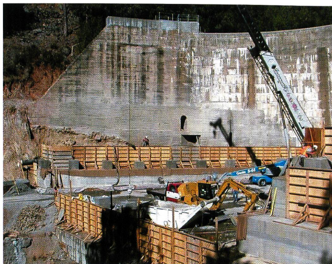
Bild 6. Erdbebenverstärkung der Weber-Gewölbemauer. Verstärkung der Widerlagerpfeiler durch RCC-Block, links: Endzustand, rechts: Bauzustand (Fotos: D. Babbitt).
