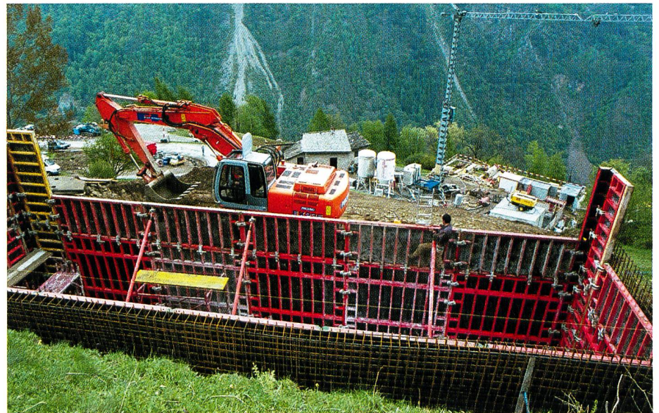
Bild 11. Bau der oberen Wasserschlosskammer.
