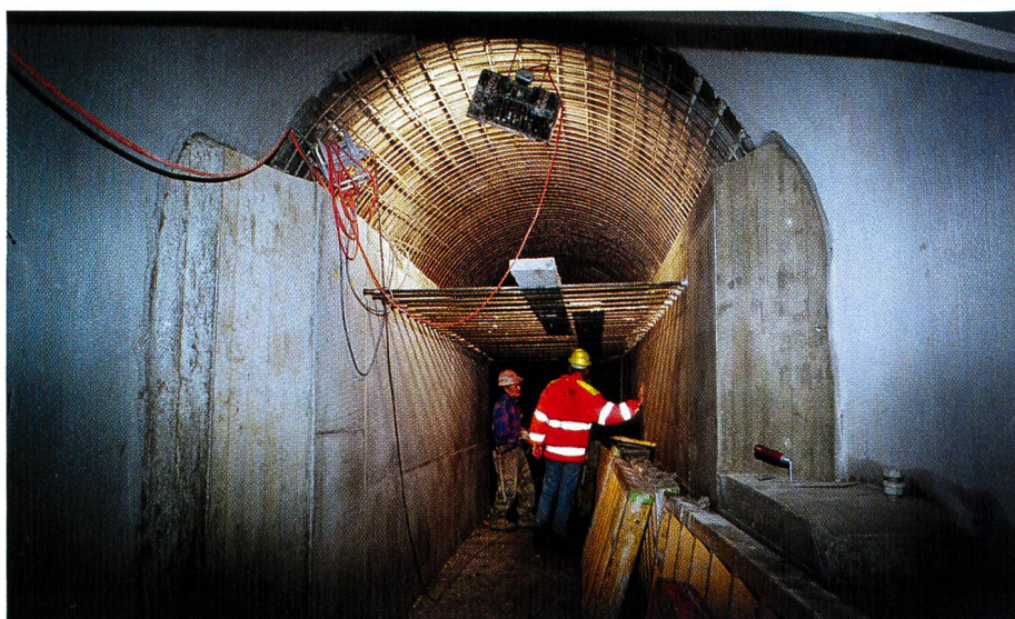
Bild 14. Statische Verstärkung am Stollenende mit Betonwänden und Zugstangen.
