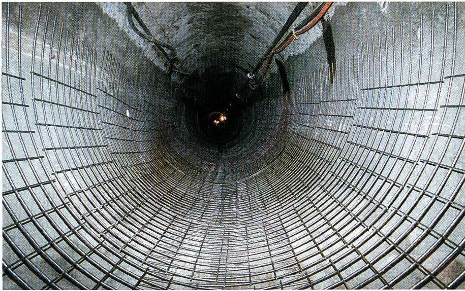
Bild 7. Armierung der Stollenverstärkung in der Lockermaterialstrecke.
