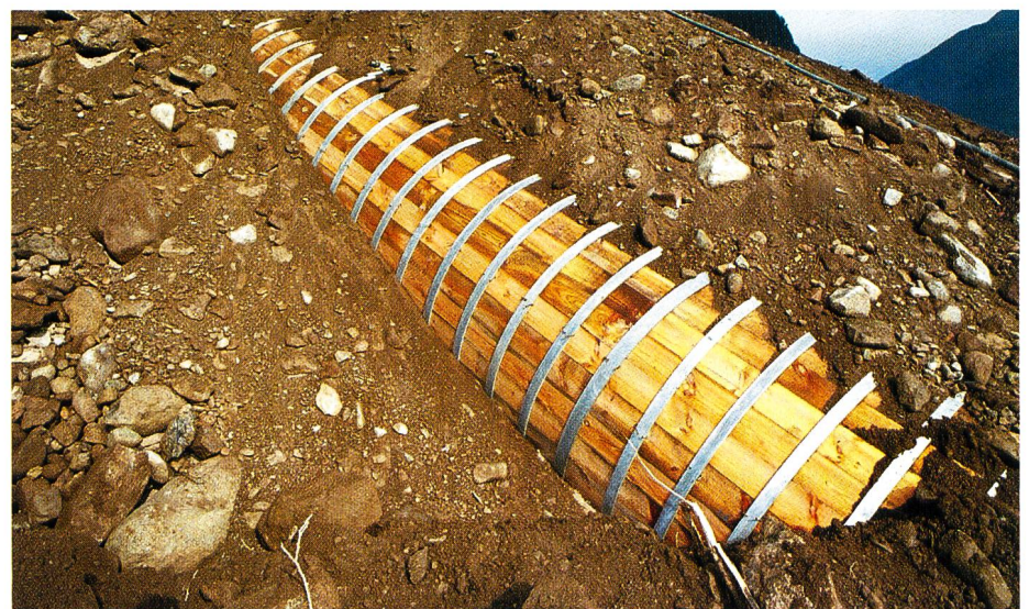
Bild 12. Holzdruckleitung.
