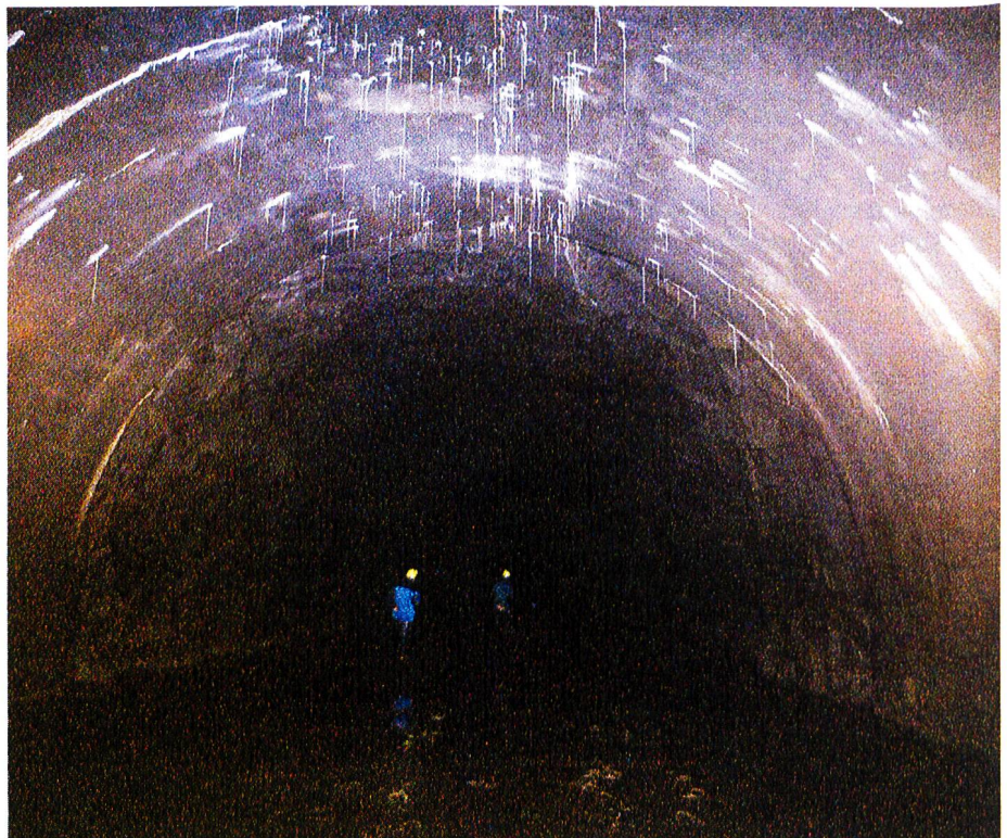
Bild 5. Reservoirkammer des Wasserschlosses.
