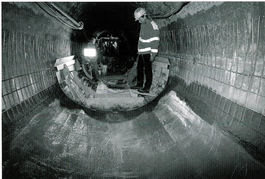
Bild 8. Betonierung des Sohlbereichs mit Gleitschalung.
