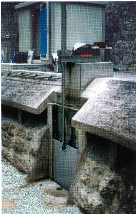
Bild 1. Dotierschütze im Wasserschloss, im Hintergrund das neue Betriebsgebäude.
