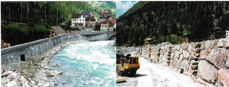
**Bild 1. Ufermauern mit Rauigkeitsrippen in Gurtellen an der Reuss (links) und in Saas Almagell an der Vispa (rechts).**
