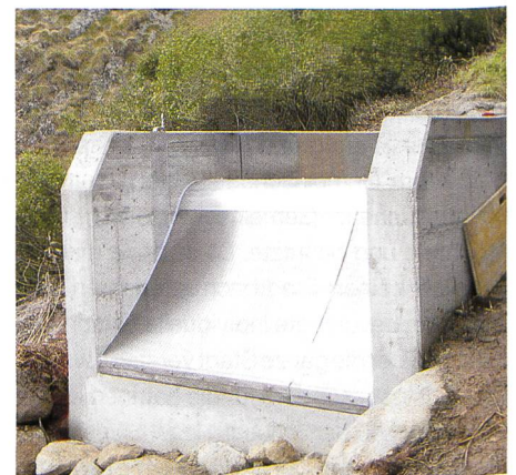
Bild 2. Fassungsschacht samt Rechen unmittelbar nach der Fertigstellung.
