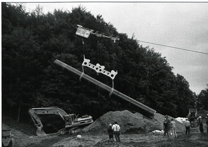
Transport und Versetzen Erdgasleitung, Rohrgewicht 12 Tonnen
