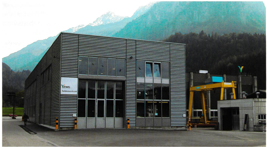
Bild 1. Übersicht über die Turbinenwerkstatt KWO.
