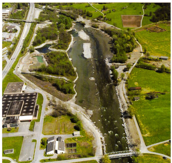
Bild 2. Übersicht Aue Pascoletto nach Realisierung der Flussaufweitung, Bild 2000.
