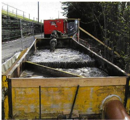
**Bild 8. Absetzmulde für grobkörniges Material.**
