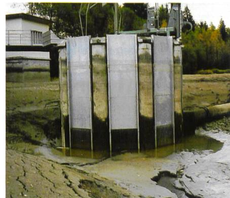
**Bild 3. Sedimentablagerungen im See vor Fassungs-turm.**
