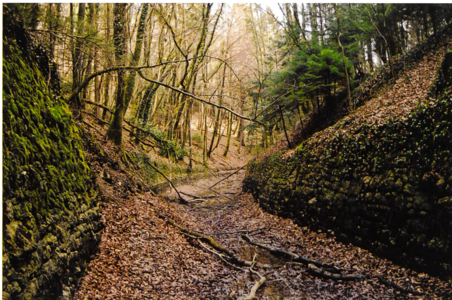
Bild 1. Überreste des mit Trockenmauern eingefassten Canal d'Entreroches in der Klus des Mormont (Foto: Schweizer Heimatschutz).
