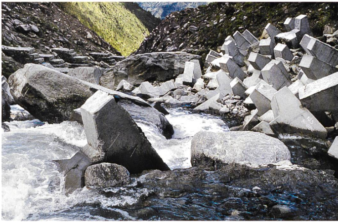
Bild 3. Blockwurfartige Struktur aus CABs zum Schutz eines Prallhangs im Charnawati River. Die obersten Elemente stellen eine Reserve dar und rutschen nach, wenn die CABs am Böschungsfuss abtransportiert werden.
