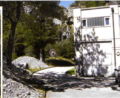
Bild 1. Kraftwerk Dala (links) mit der Zentrale Bild 2, (oben).
