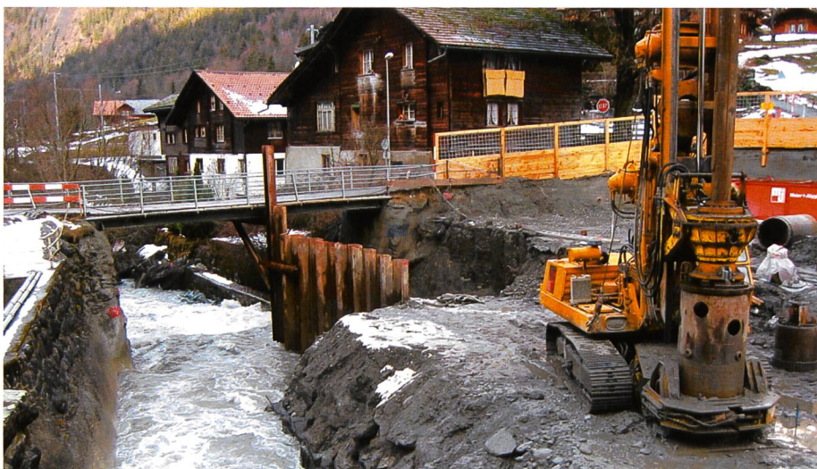
Bild 1. Vorgebohrte Spundwände als Baugrubenabschluss.
