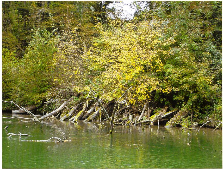
Bild 2. Mit dem Anlegen der Raubäume wird gleichzeitig auch die Verjüngung der vielfach überalterten Uferbestockungen eingeleitet. Nach wenigen Jahren gestaltet sich um die Raubäume eine üppige Vegetation, die das Wegschwemmen der Bäume zusätzlich verhindert (Foto: U. Fischer).
