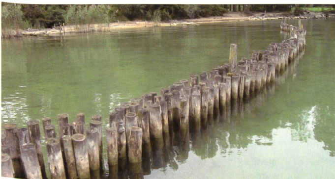
Figure 6. Photo d'une palissade utilisée sur le Lac de Biene pour la protection du rivage contre l'érosion.
