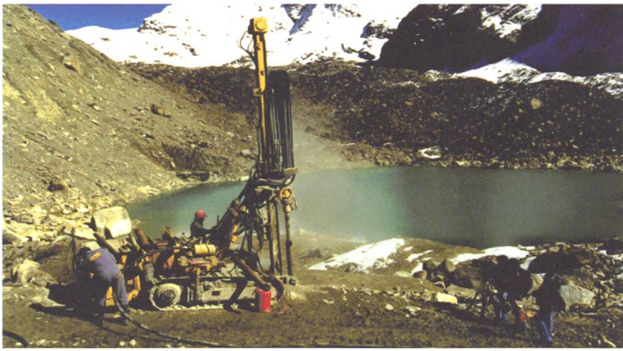
Bild 6. Verstärken des Dammes bei Grubensee Nr.1.
