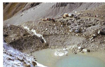
Bild 4. Verstärkter Damm mit neuer Hochwasserentlastung beim Weingartensee.
