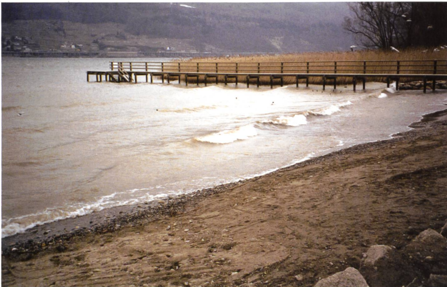
Bild 4. Je seichter die Flachwasserzone und je geringer die Schüttneigung, desto feineres Material kann geschüttet werden.
