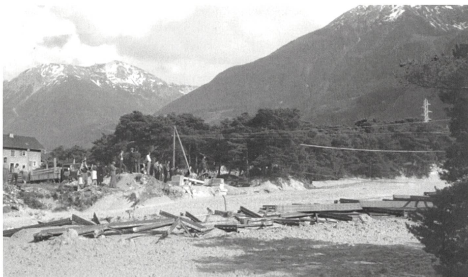
Bild 3. Der Murgang am 3. Juni 1961 zerstörte die Brücke über den Illgraben. (Kreisforstamt IV, Kt. VS).
