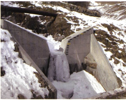
Bild 4. Manuelle Pegelmessstelle im Gebiet Simplon Süd (links), automatische Niederschlagsmessstation im Gebiet Verbier (rechts).
