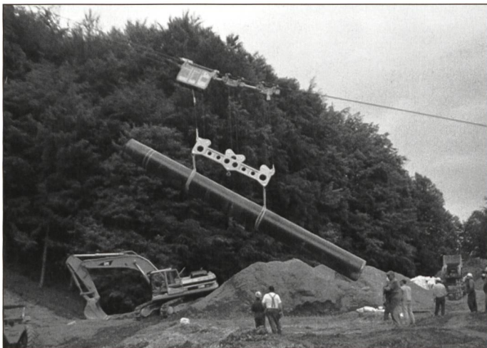
Transport und Versetzen Erdgasleitung, Rohrgewicht 12 Tonnen
