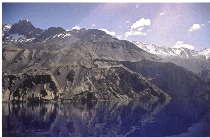
Figure 3. Masse instable en rive droite.
