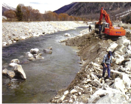
Bild 5. Ökologische Baubegleitung: Der ökologische Baubegleiter ist am Bau mit weitreichenden Befugnissen ausgestattet. So gibt er der Bauleitung und dem Baggerführer konkrete Anweisungen zur Massnahmenumsetzung. In den hier vorgestellten Beispielen bespricht der ökologische Baubegleiter die richtige Positionierung von Sohlblöcken als Stabilisierungs- und Strukturierungselemente im Neuen Flaz.
