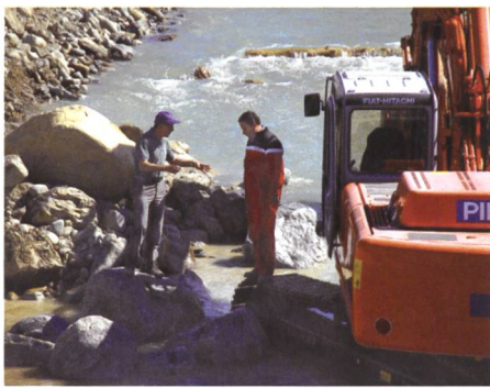
Bild 5. Ökologische Baubegleitung: Der ökologische Baubegleiter ist am Bau mit weitreichenden Befugnissen ausgestattet. So gibt er der Bauleitung und dem Baggerführer konkrete Anweisungen zur Massnahmenumsetzung. In den hier vorgestellten Beispielen bespricht der ökologische Baubegleiter die richtige Positionierung von Sohlblöcken als Stabilisierungs- und Strukturierungselemente im Neuen Flaz.
