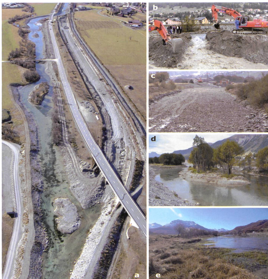
Bild 16. Die En-Ausleitung: Die neue Gestalt des En unterhalb von Samedan: a) Verlauf der En-Ausleitung von Fussgängerbrücke bis Kantonsstrassenbrücke (nach der Flutung, Nov. 2005); b) Moment der En-Ausleitung am 22. September 2005; c) leerer ehemaliger En-Kanal nach Ausleitung; d) eines der als Insel erhaltenen Uferstücke des ehemaligen En-Altlaufs; e) rechtes, erhaltenes Ufer des ehemaligen En-Altlaufs.
