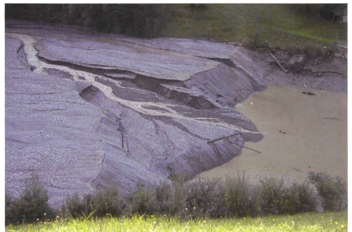
Bild 5. Ablagerungen im Becken Chäppelistutz, Aufnahme vom 22. September 2005.
