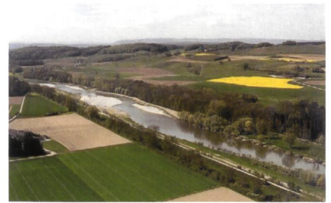
Bild 3. Flussaufweitung an der Thur bei Niederneunforn. Linke Flusseite mit Damm als Schutz der landwirtschaftlichen Siedlungen. Rechte Seite mit altem Auenwald. Quelle: BHAtteam, Ch. Hermann.
