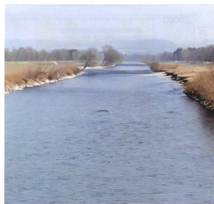
Bild 7. Unterlauf: Doppeltrapezprofil mit kleiner Aufweitung.
