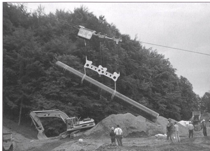
Transport und Versetzen Erdgasleitung, Rohrgewicht 12 Tonnen
