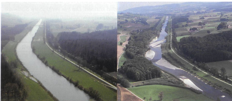
Bild 1. Die Thur bei Altikon: Links nach der Korrektur des 19. Jahrhunderts, rechts nach der Aufweitung des Hauptgerinnes. Schon zwei Jahre nach der Revitalisierungsmassnahme hat sich die morphologische Vielfalt deutlich verbessert.
