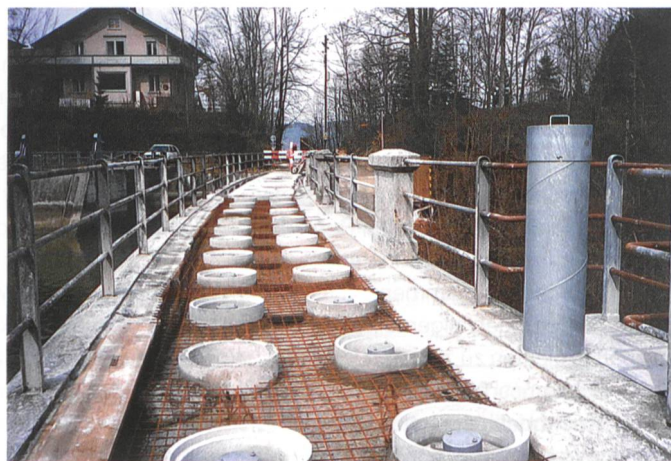
Bild 4. Kronenbalken mit Ankerköpfen, Gübsenseemauer.
