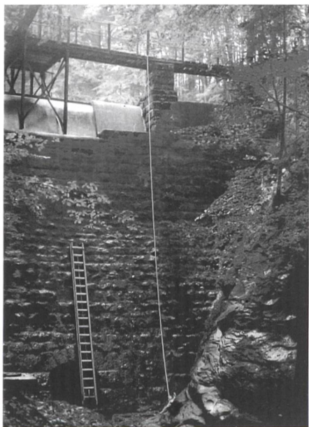
Bild 1. Alte Staumauer List, Heiden.
