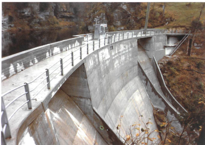
Bild 10 (oben). Verkleidete Staumauer Muslen.
