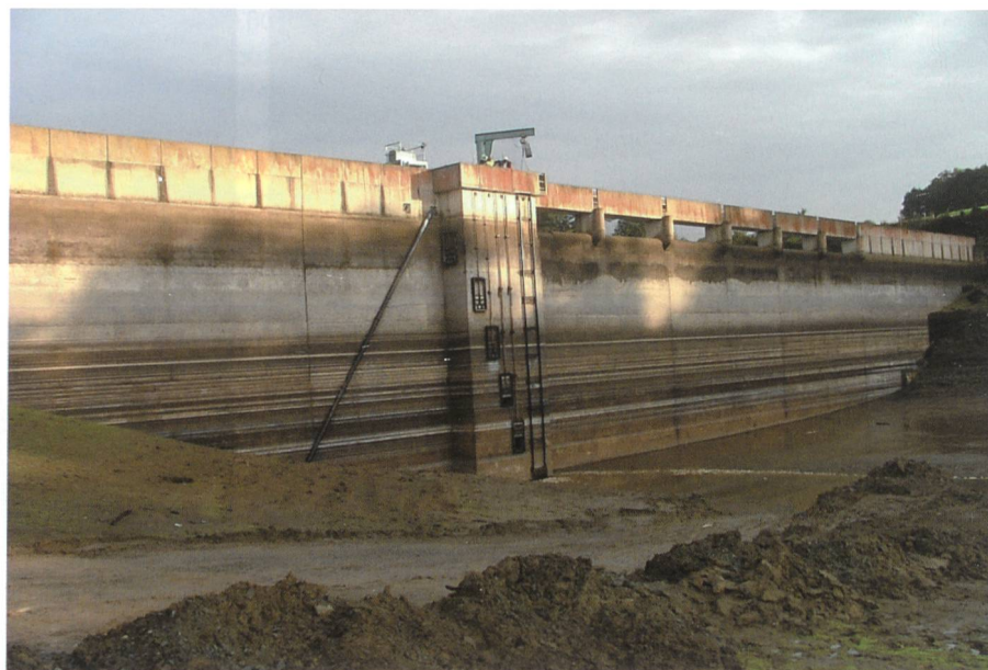
Figure 5. Parement amont du barrage de Bois Joli ( H = 24\text{ m} , 3\text{ hm}^3 ) lors du récent examen décennal complet.
