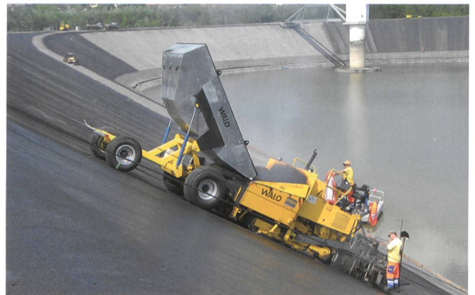
Bild 10. Asphaltarbeiten über Wasser.
