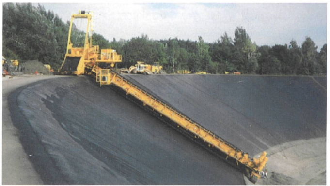
Bild 9. Brückenfertiger im Einsatz beim Pumpspeicherbecken Glems, 1996.
