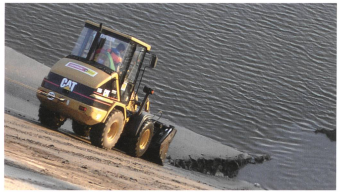
Bild 4. Sedimenträumung.
