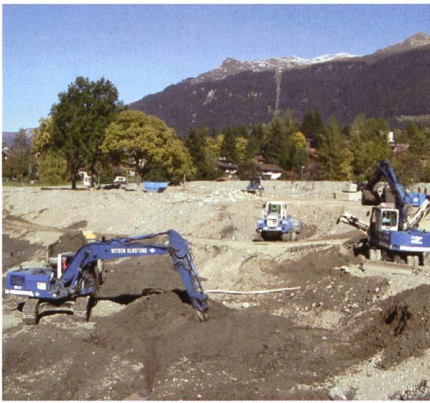
Bild 9. Ausbaggerung des Aeujabeckens nach dem Hochwasserereignis von 2005.
