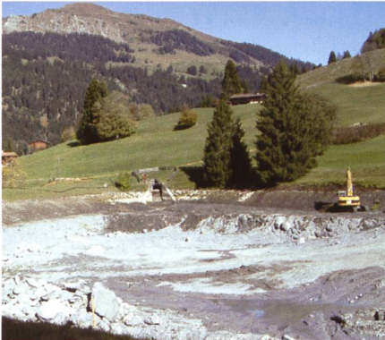
Bild 10. Plävigginnenbecken während Optimierung des Stauvolumens.
