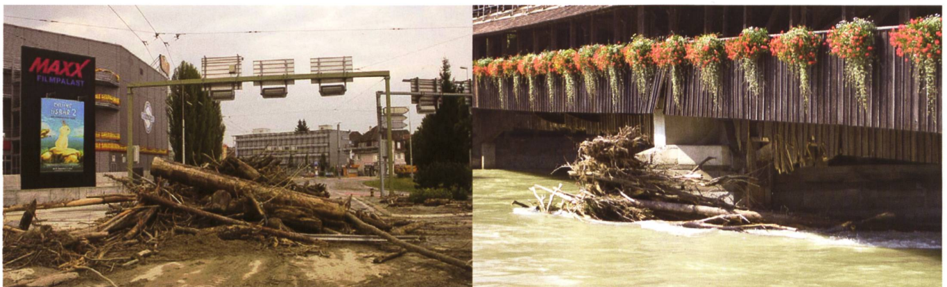
Bild 2. Beim Hochwasser 2005 abgelagertes Schwemmholz in Emmen (links) und Verklausung bei der Holzbrücke Sins (rechts).
