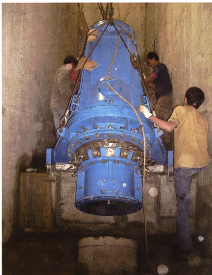
Bild 8. Einbau einer Propellerturbine aus Indonesien im Rahmen der Nord-Süd-Kooperation.
