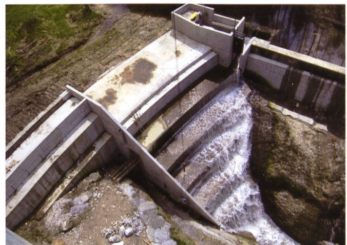
Bild 6. Kaskadenschussrinne über die nach vorn abgestützte Pfeilermauer.
