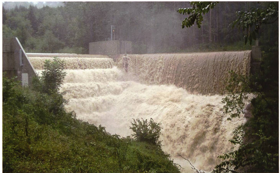
Bild 9. Kaskadenabfluss beim Hochwasserereignis vom 17. September 2006.
