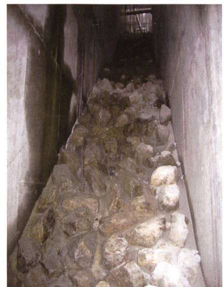
Bild 10. Entleerte obere Kammer der Fischschleuse mit einer Sohle aus Natursteinblöcken.
