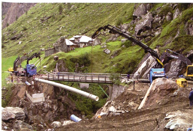
Bild 3. Montage einer 23 m langen Stahlrohrbrücke.
