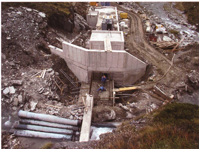
Bild 1. Bau der Wasserfassung (Vordergrund) und Entsanderanlage (Hintergrund) auf 2000 m ü.M.: Erkennbar sind Rohre für die Bachumleitung während der Errichtung des Tiroler Wehres.
