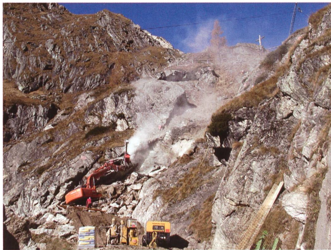
Bild 2. Sprengabtrag in einem Steilhang auf über 1900 m ü.M.
