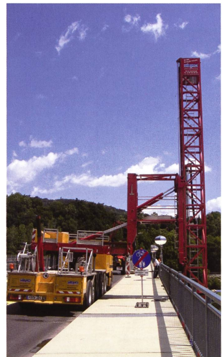
Bild 7. Montage unter der Strassenbrücke.
