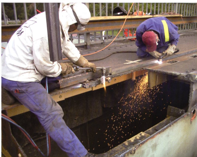
Bild 12. Aufschneiden des Kranbahnträgers.
