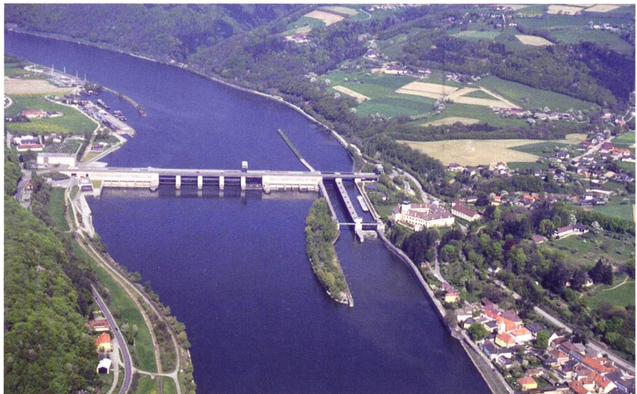
Bild 1. Luftaufnahme vom KW Ybbs – Persenbeug.
