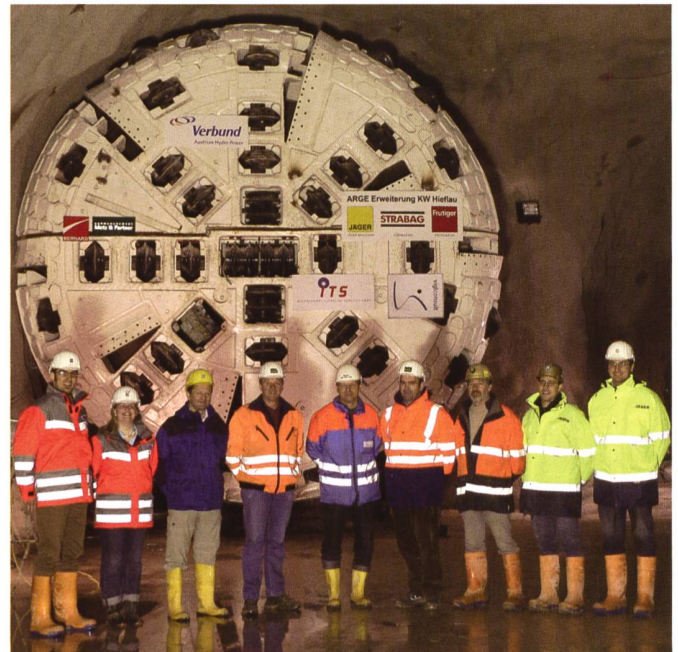
Bild 8. Fräskopf im Verzweigungsbereich des neuen Triebwasserweges.
