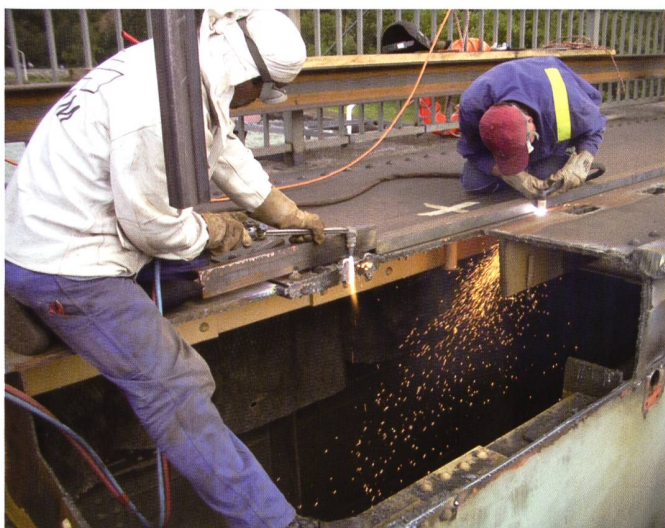
Bild 12. Aufschneiden des Kranbahnträgers.
