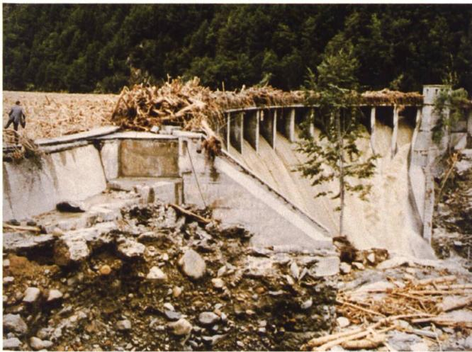
**Bild 4. Verklauungen an der Hochwasserentlastungsanlage Palagnedra 1978.**
