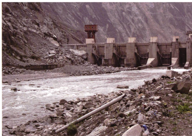
Bild 4. Wehr des Flusskraftwerkes Futan.
