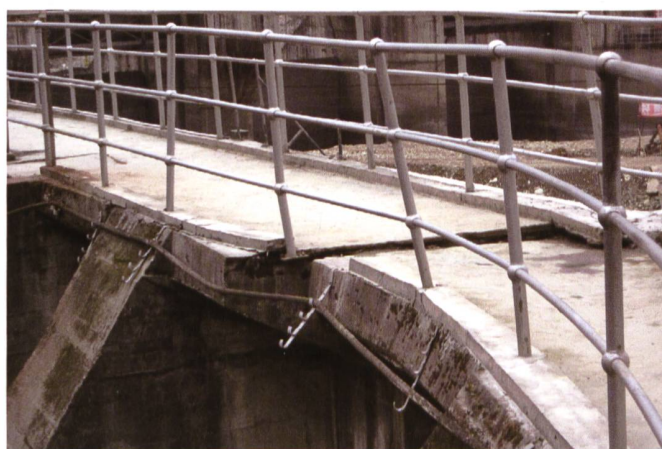
Bild 8. Yingxiuwan: Differentielle Bewegungen an Gehstegfugen.
