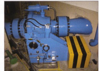
Kugelschieber nach Revision in Betrieb
