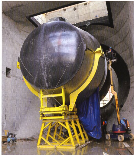
Bild 1. Die Montage der ersten Maschine.
