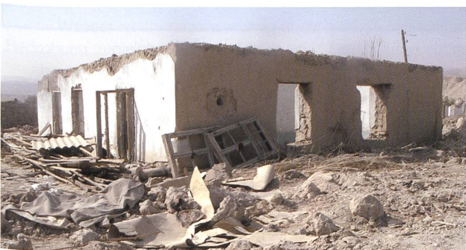
Bild 36. Zerstörungsbild eines Murgangs («SchlammLawine») in Khuroson/Tadschikistan (Bild: DEZA – Humanitäre Hilfe 2009).
